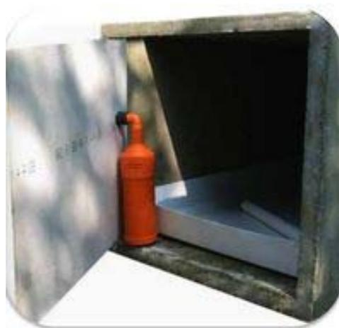
**Immagine n°9:** Esempio di trasformazione di loculo esistente tradizionale nel tipo "aerato". Sono visibili il filtro depuratore (rosso) collegato alla lastra di sigillo e la vaschetta raccolta liquidi (bianca) inserita internamente al vano esistente.
